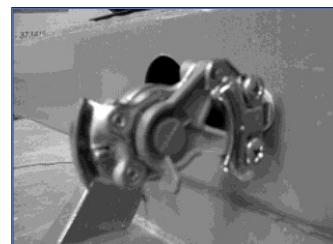
Cerrado: Instalación protegida
